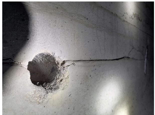
图 3.2.2.3-2 790-780m 处裂缝, 宽 2mm, 深 50mm, 长度 7m
