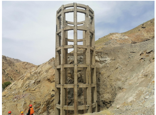
图4 第二套排洪系统3#溢水塔外观照
