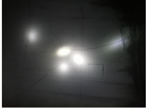
图 3.2.2.2-2 3030 米处开裂, 宽 5mm, 深 80mm
