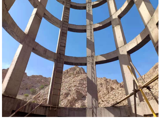
图2 第一套排洪系统3#溢水塔内景照
