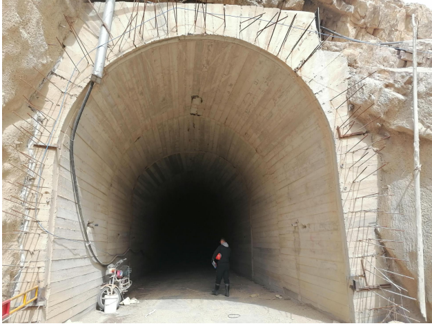
图1 第一套排洪系统主隧洞外观照
